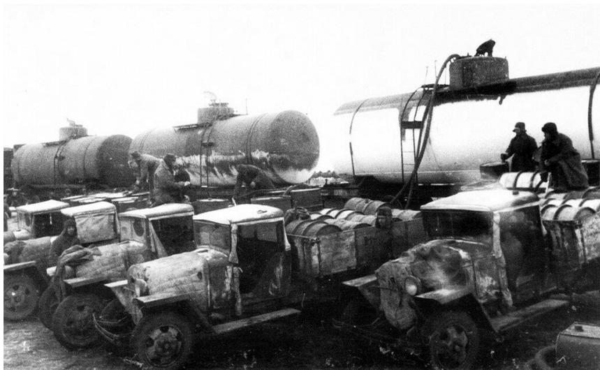
**Грузовики ГАЗ-ММ, используемые в качестве бензовозов, во время заправки на одной из станций под Сталинградом. Капоты моторов укрыты чехлами, вместо дверей — брезентовые клапаны.**
